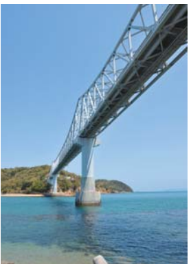
青い海に映える純白の鹿島大橋が、倉橋島と鹿島を結ぶ
